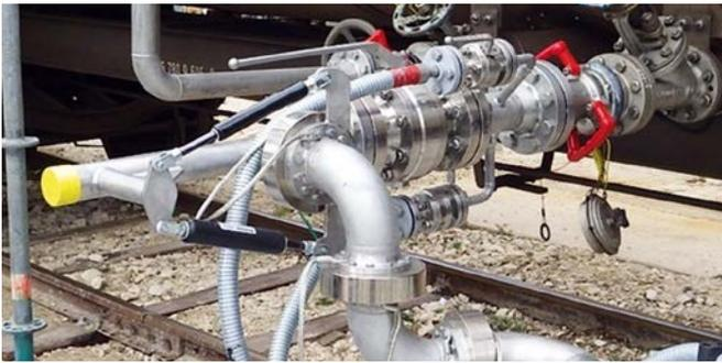
2: Zu den Kernkomponenten der Umschlagsanlagen gehören die gas- und flüssigkeitsdichten Drehgelenke der Verladearme.
