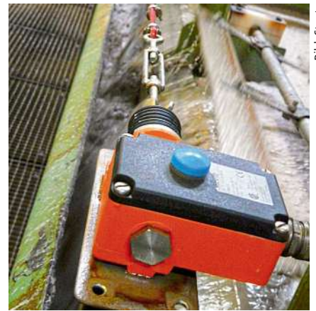
Die Flotationsanlagen sind über Seilzug-Notschalter abgesichert.
